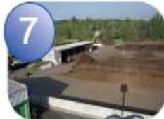
7 Plate-forme pré- collecte 94 rue du Port Thureau 16000 ANGOULEME 0 800 77 99 20
